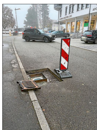
Schachtsanierung im Jahresbau
