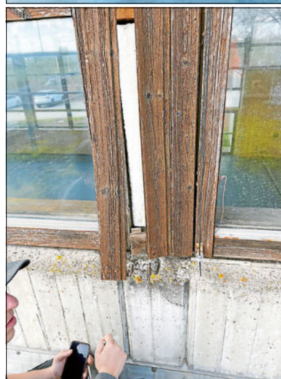
Zustand vor der Sanierung
