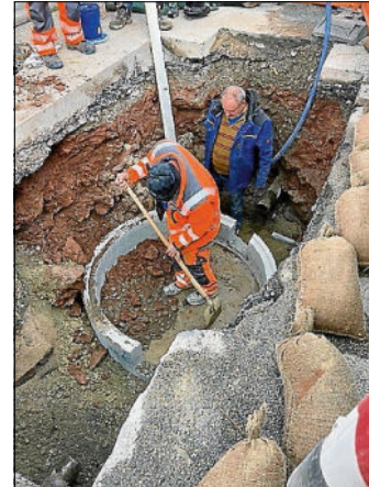
Sanierung Wasserschacht in Liebelsberg
