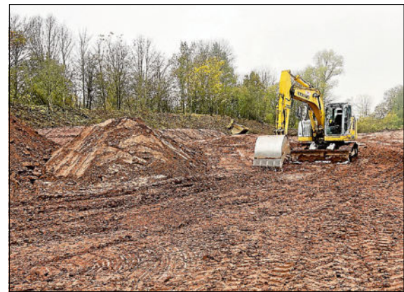
Regenrückhaltebecken am Dürrbach in Liebelsberg
