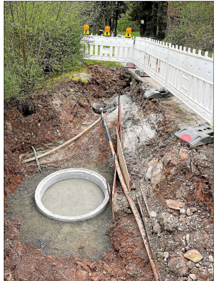
Reparatur Abwasser-Druckleitung Lautenbachhof
