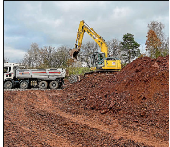
Regenrückhaltebecken am Dürrbach in Liebelsberg
