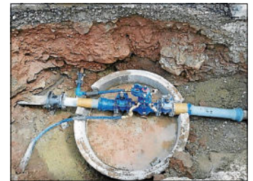
Sanierung Wasserschacht in Liebelsberg
