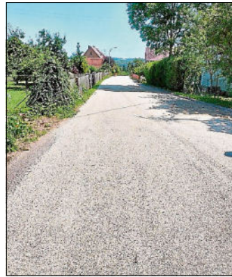
Oberflächenbehandlung von defekten Straßenbelägen mittels Bitumenemulsion und Moränesplitt
