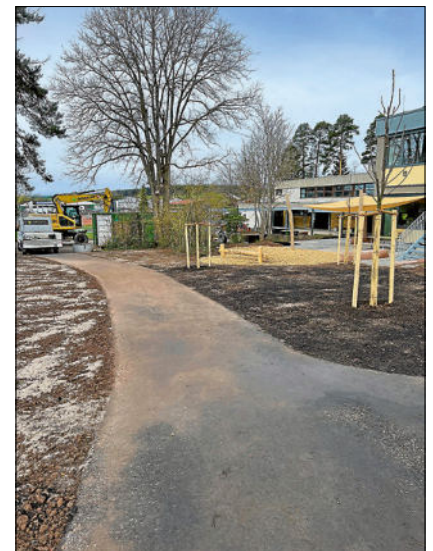
Anlegen der Außenan- lage an der Gemein- schaftsschule
