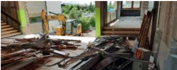
Bild links: Fehlt da nicht eine Wand? Genau! Die Fensterfront in Richtung „Lückenschluss“ musste weichen. Im Vordergrund: Metallschrott der Entkernungsarbeiten. Bild rechts: Das alte und künftige „Helmut-Büro“.
